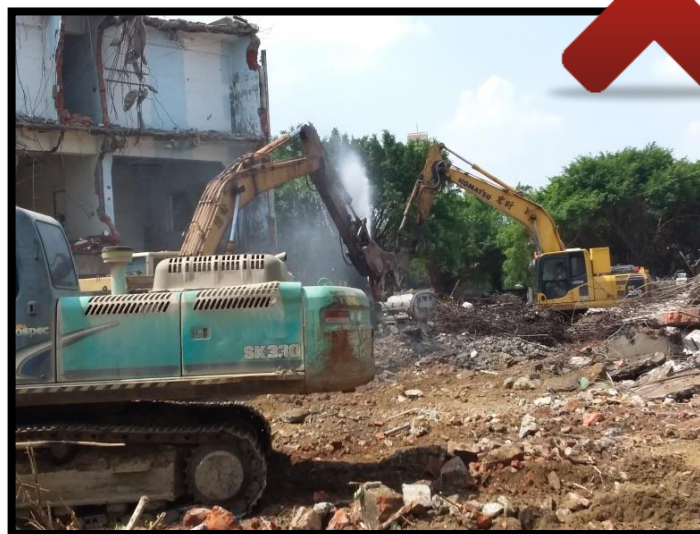
灑水但結構體未包覆防塵網(布) (缺失記點4點)
