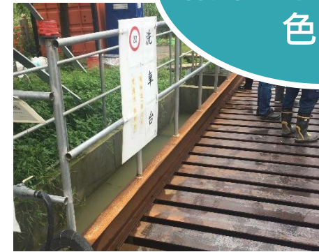
(2)廢水處理設備 (3)告示牌
