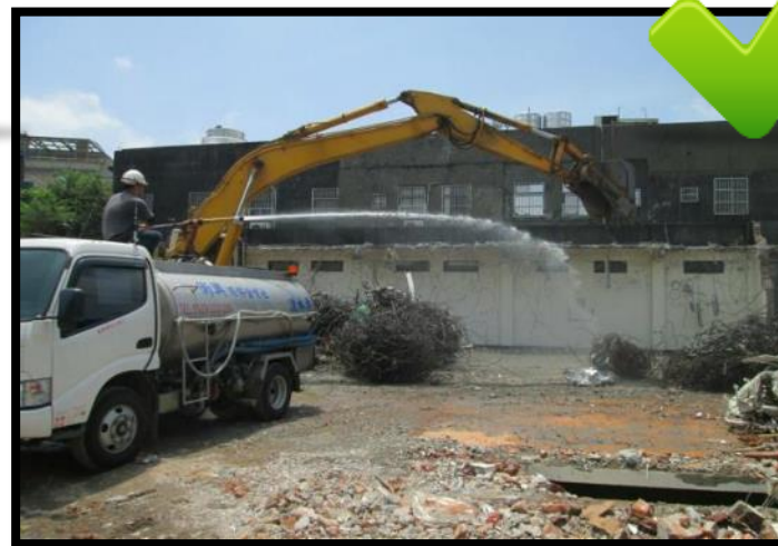
拆除作業進行時，配合加壓噴灑水
