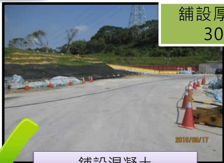
鋪設混凝土
