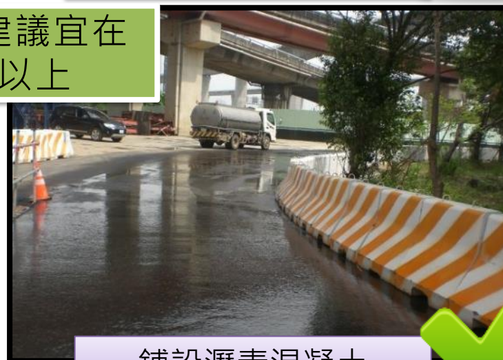
鋪設瀝青混凝土
