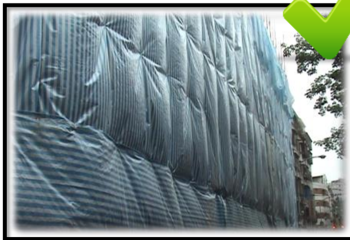
拆除結構體外包覆防塵布
