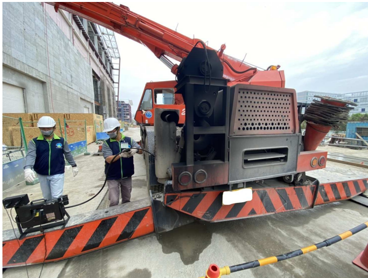
施工機具檢測照片
