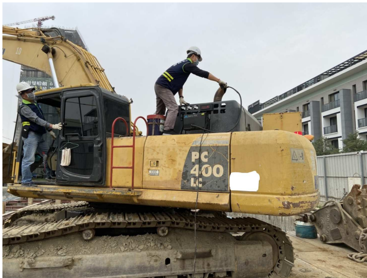
施工機具檢測照片
