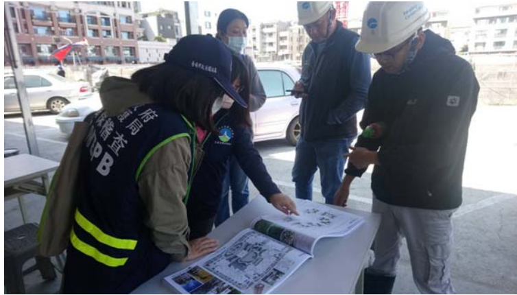
宣導自主管理標竿工地
