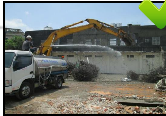
拆除作業進行時，配合加壓噴灑水
