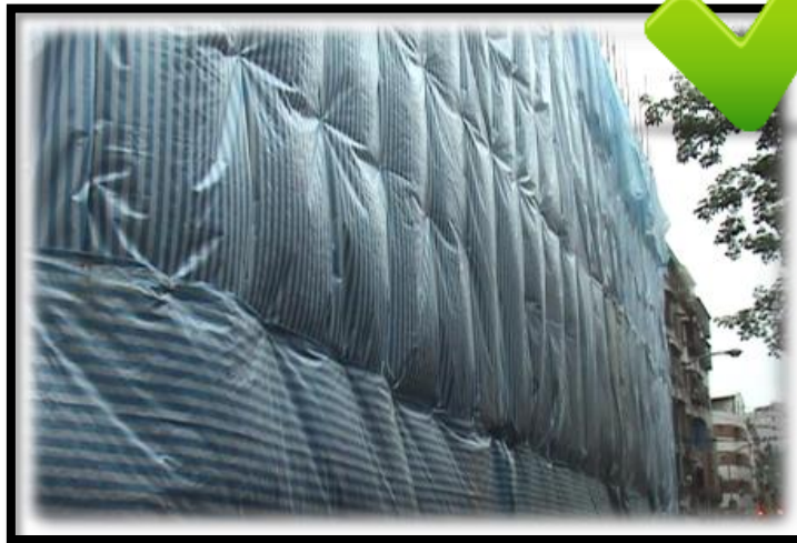
拆除結構體外包覆防塵布
