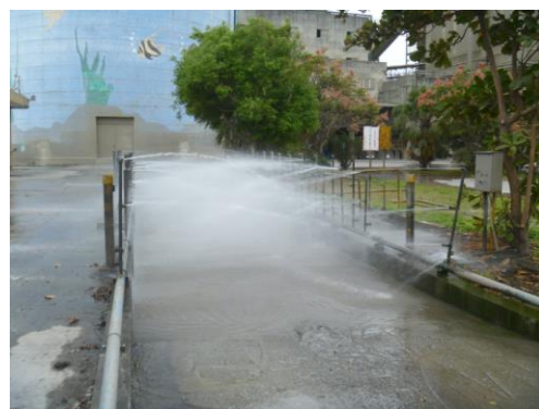
自動洗車設備
