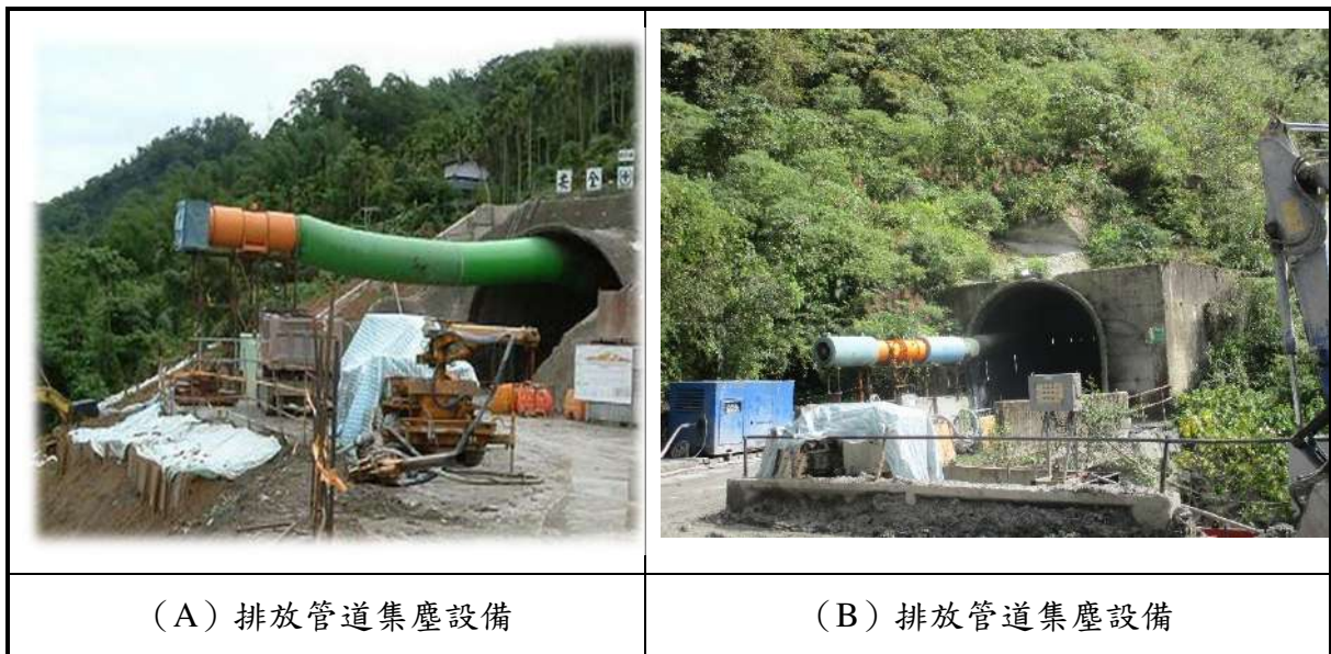
圖十九 粒狀物排放管道應採行之防制設施內容及標準
